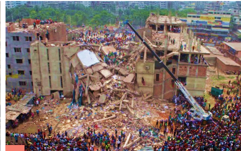
Обрушение здания в Саваре (Бангладеш)
