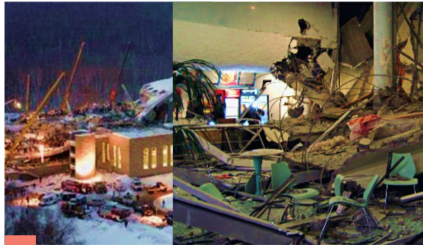
Обрушение крыши Трансвааль-парка
