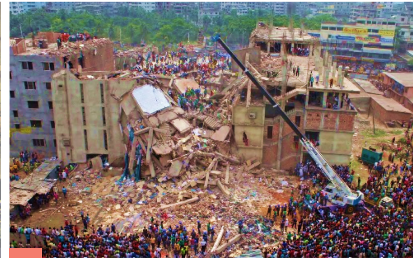
Обрушение здания в Саваре (Бангладеш)
