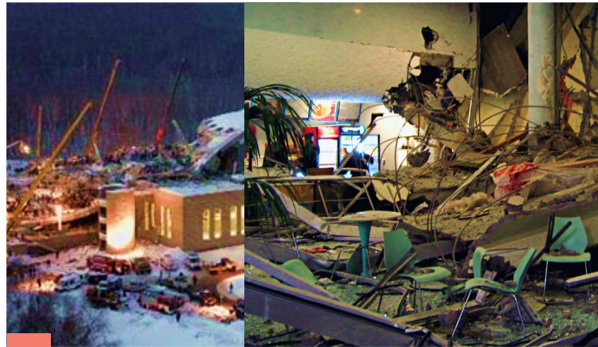
Обрушение крыши Трансвааль-парка
